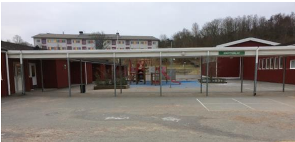
Figur 2. Områdets centrala skolgård. Bild tagen från norr.
